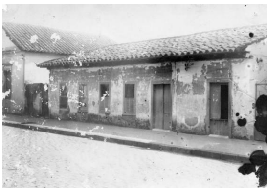
Casa que pertenceu a Bernardo Alves Pereira, localizada, então, na Rua Visconde do Rio Branco nº 42-44, onde foram realizadas as primeiras reuniões da Câmara Municipal a partir de 1874 167 .
