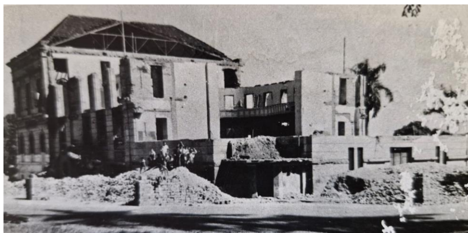
Demolição do Theatro Carlos Gomes, em 1944.
