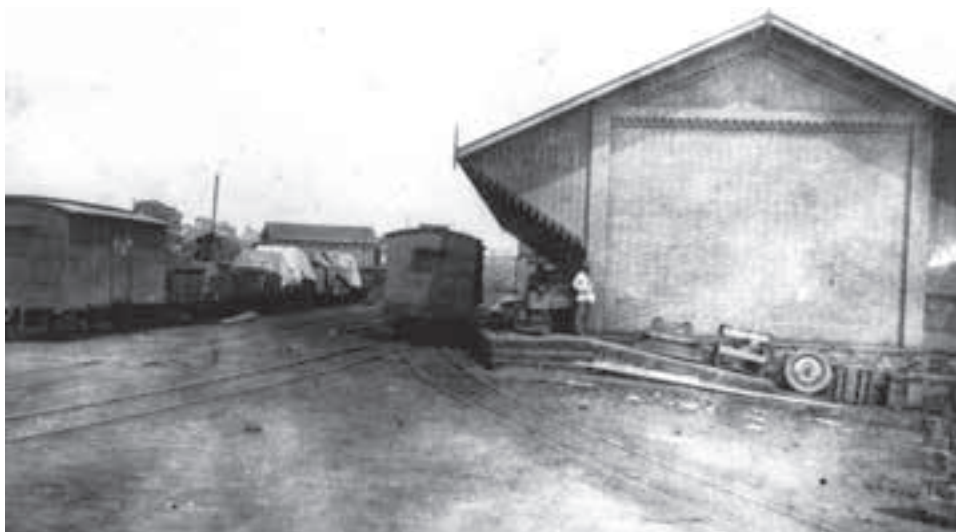
FOTO DA ESTAÇÃO EM 1910 , chegada dos materiais vindos da Alemanha para a usina de força e luz que estava sendo construída no rio Sapucaí
