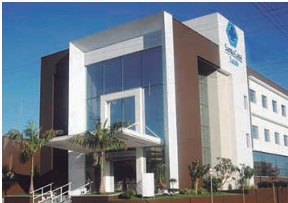
FACHADA DA ALA JOSÉ OLYNTHO FORTES JUNQUEIRA, da Santa Casa de São Joaquim da Barra.
