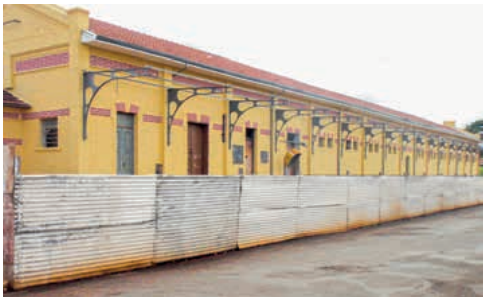
FOTOS DA REVITALIZAÇÃO da Estação Mogiana
