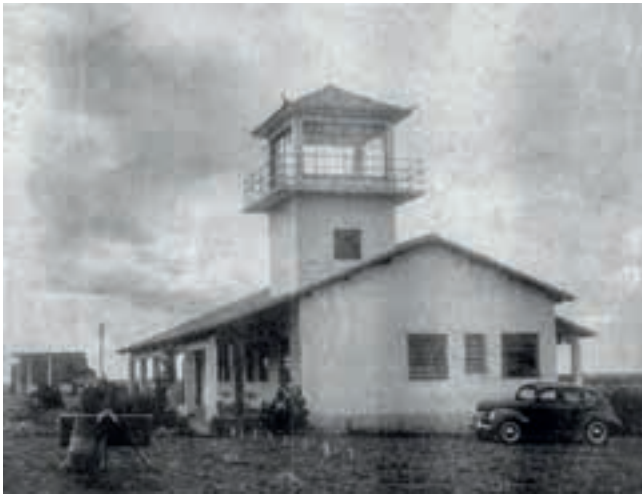
FOTO DA DÉCADA DE 1950 , prédio da torre de comando do aeroporto de São Joaquim, hoje Aerobarra.
