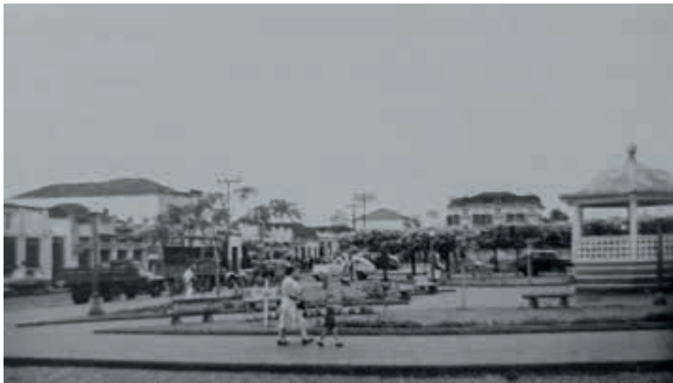
A FOTO DE 1950 MOSTRA O NOSSO ANTIGO CORETO, com as características da construção de 1935
