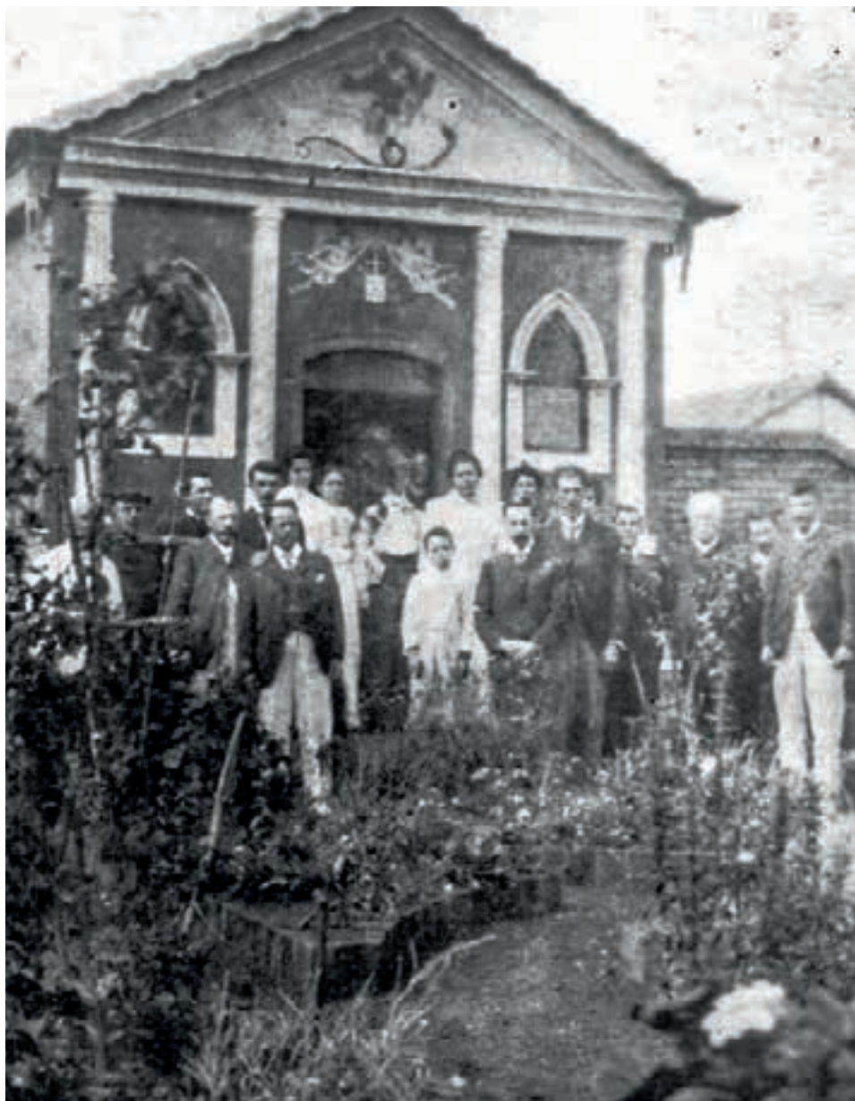
CAPELA DO DR. JOSÉ ESMERALDO DE OLIVEIRA (foto de 15.8.1904), foi demolida em 1927, para construção da casa de André Cardoso, filho do Major Cardoso que seria prefeito em 1929
