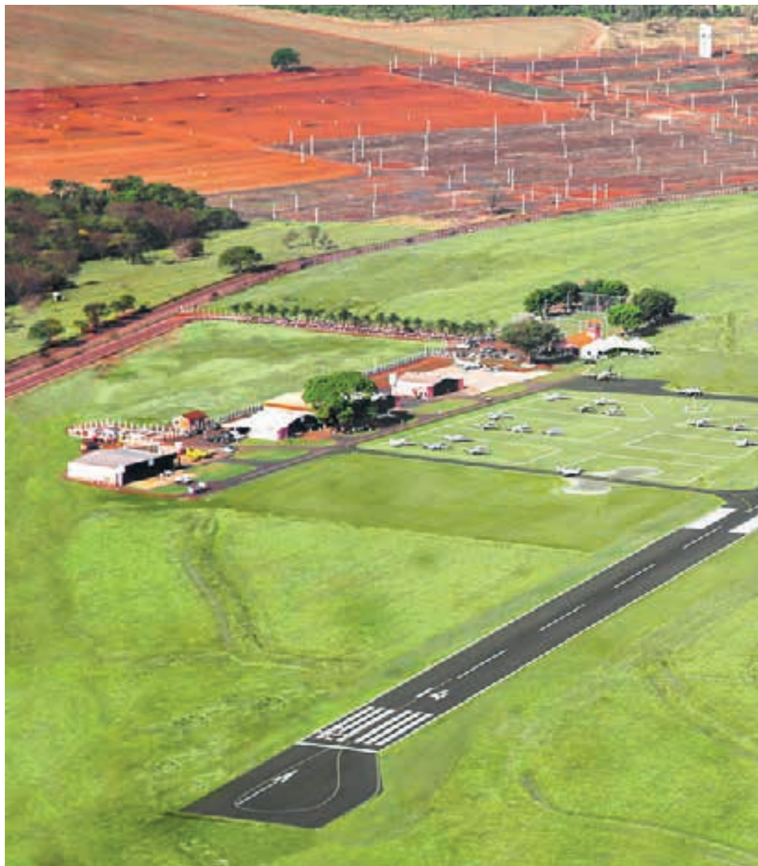
PISTA DE POUSO ATUAL com 1.380 metros de comprimento, 23 metros de largura.
