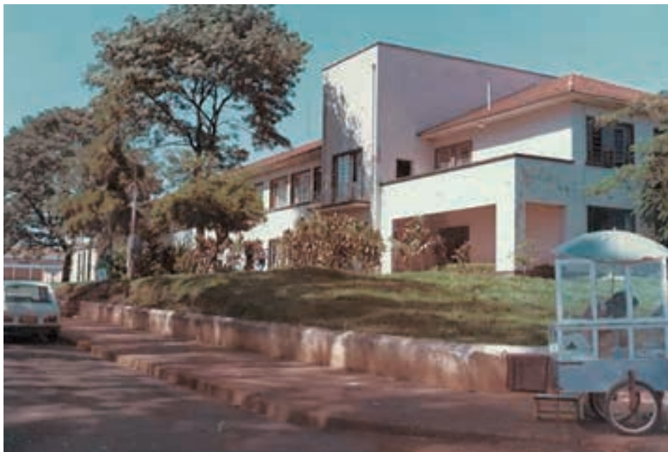
GINÁSIO ESTADUAL , hoje escola Professora Genoveva Pinheiro Vieira de Vitta, ainda sem os muros.
