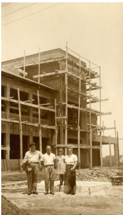
Figura 93 – Construção do Ginásio
