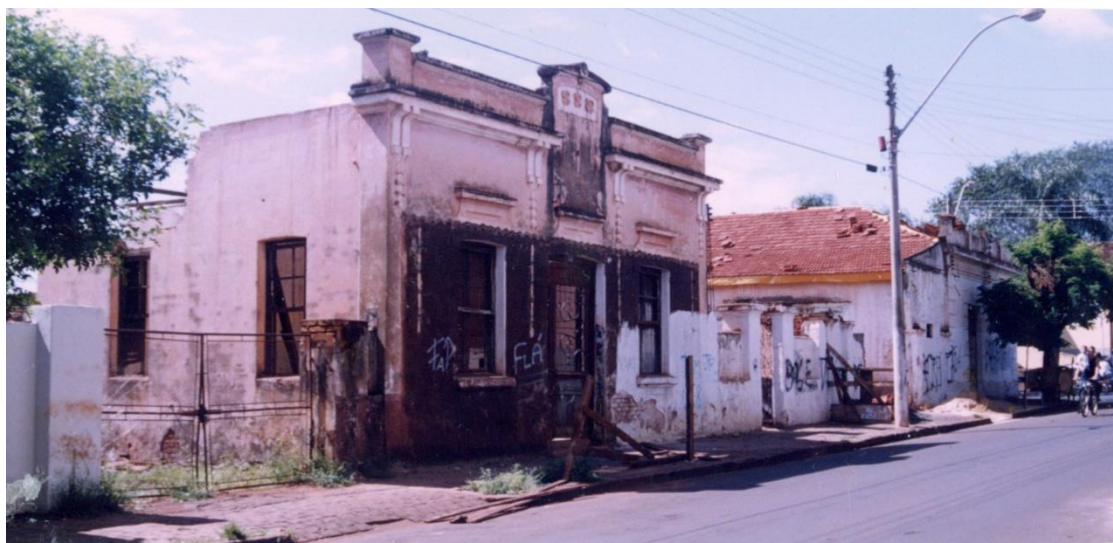
Figura 161 – Foto de década de 1990, pouco antes da demolição do histórico Hotel Machado
