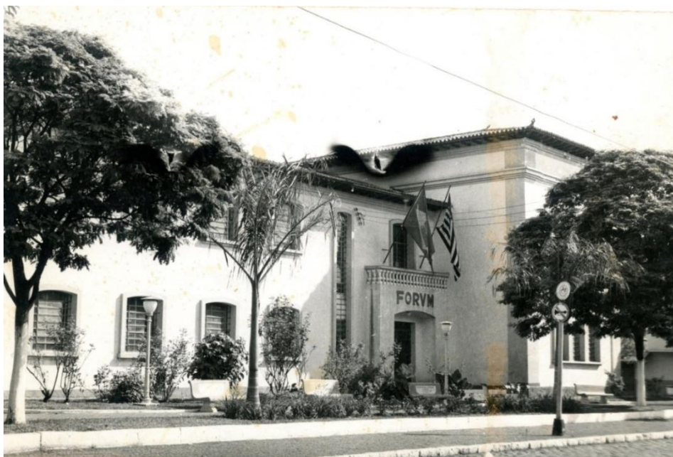
Figura 38 – Fachada do Antigo Fórum de São Joaquim da Barra, na rua São Paulo, esquina com a Pernambuco, hoje abriga a Secretaria da Educação Reginaldo Sartorato.
