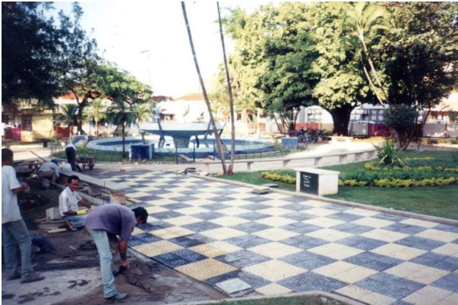
Figura 62 – Assentamento do novo piso hidráulico na praça Sete de Setembro, ao fundo a fonte Sonora Dr. Mário Rossi, inaugurada em 1966.
