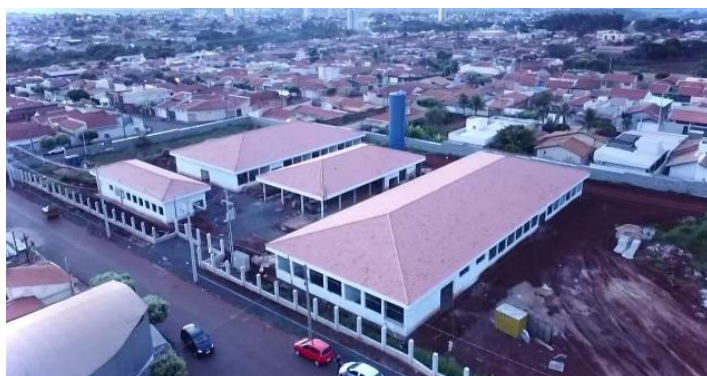
Figura 72 – Escola Nelson Schmidt em sua fase final de construção
