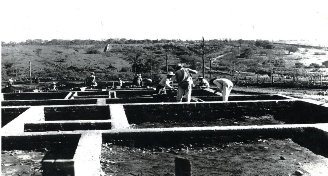
Figura 28 – Foto de 1972. Primeiro conjunto das casas da COHAB de São Joaquim. Em 180 dias, foram construídas 44 casas na Vila Martus, nas imediações do Cemitério durante a administração do prefeito Lair Louveran Deienno. A empresa construtora foi a CORMAF, da cidade de Santa Cruz do Rio Pardo. As casas custaram entre Cr$ 9.917, 070, com dois quartos e Cr$ 11.350,470, com três quartos. Ambas com copa, cozinha, alpendre e instalações sanitárias. Ao fundo, no alto da colina, o Cemitério Municipal.
