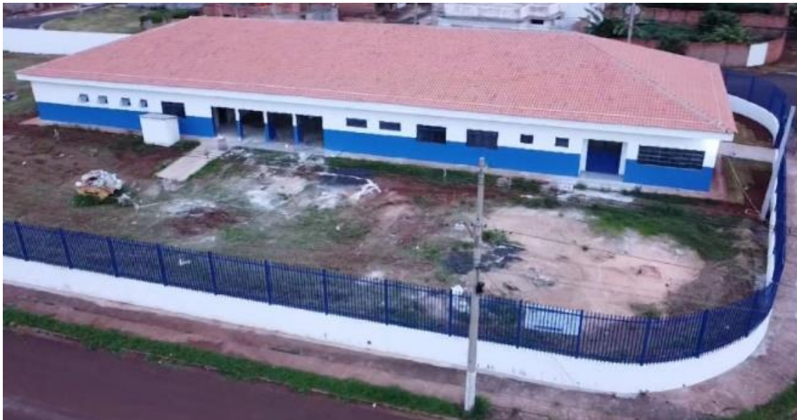
Figura 73 – Creche Municipal Erotildes Schmidt, em fase de acabamento para ser entregue até julho de 2024.
